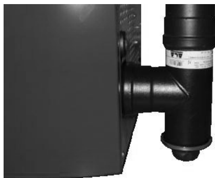
Fig. 87 - Nettoyage du conduit de fumée
