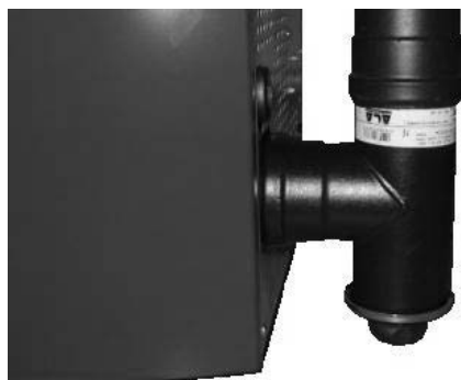
Fig. 64 - Nettoyage du conduit de fumée
