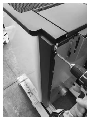
Fig. 46 - Fixer le flanc complet
