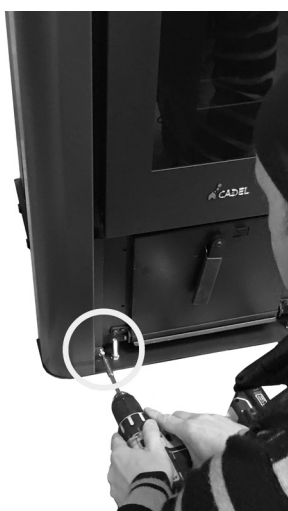
Fig. 24 - Fixation du cadre
