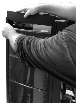
Fig. 31 - Placer le compensateur
