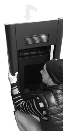
Fig. 23 - Positionnement du cadre
