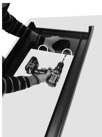
Fig. 22 - Fixation de la grille
