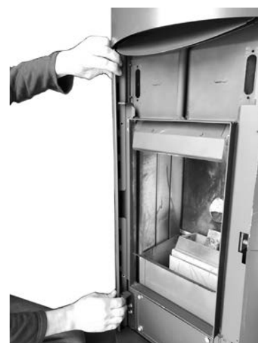
Fig. 71 - Retrait des profils avant (droit et gauche).
