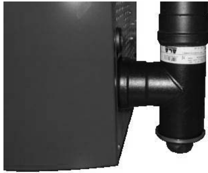
Fig. 88 - Nettoyage du conduit de fumée
