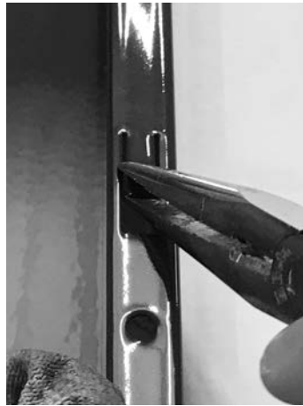
Fig. 51 - Plier les languettes
