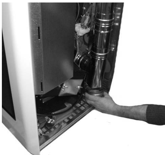
Fig. 116 - Nettoyage du collecteur des fumées
