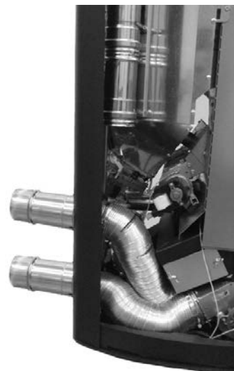
Fig. 81 - Fixation du tuyau
