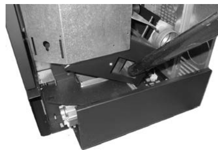
Fig. 115 - Nettoyage de la chambre des fumées
