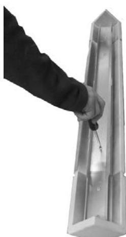
Fig. 48 - Visser les profil aux céramiques
