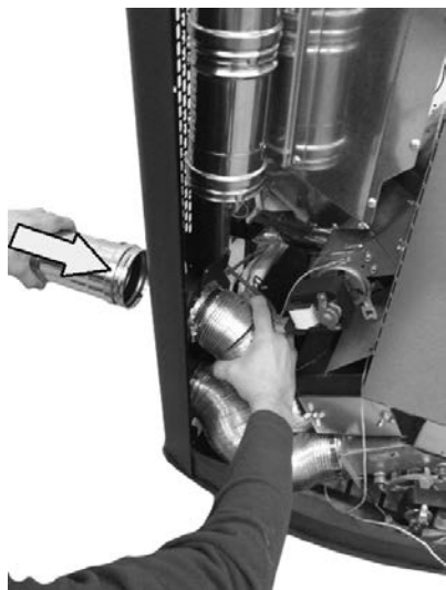
Fig. 80 - Positionnement des tuyaux pour la canalisation
