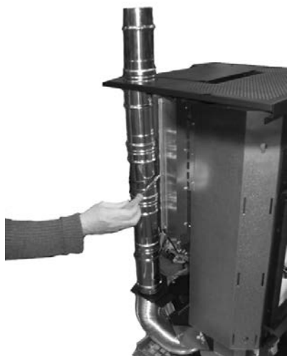
Fig. 70 - Positionnement des tubes supérieurs
