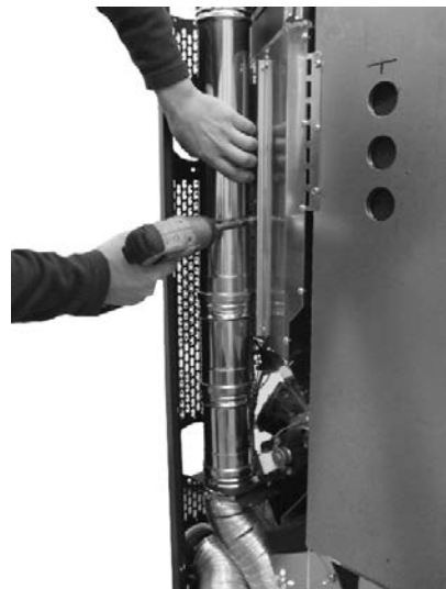
Fig. 78 - Fixation du tuyau
