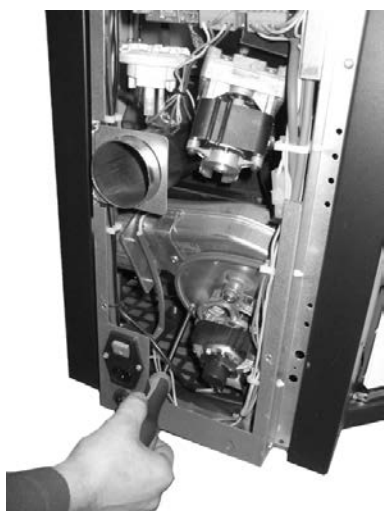
Fig. 118 - Nettoyage de l'aspirateur des fumées: phase 1
