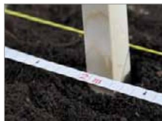
Assemblez le poteau d'angle avec sa jambe de force afin de pouvoir marquer la position du trou destiné à la jambe de force.
