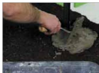
Une fois les poteaux d'angles scellés, reliez-les par une ficelle tendue entre leurs sommets. Procédez alors aux scellements des poteaux intermédiaires, avec du béton. **Alignez vous sur la ficelle et contrôlez au fil à plomb.**
