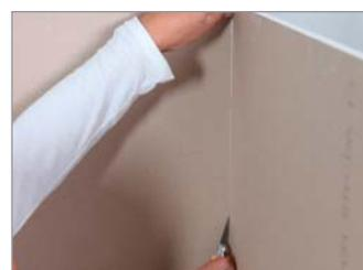
**Pour couper une plaque à vos mesures, placez-la au sol et guidez vous avec une règle de maçon pour trancher la ligne de coupe au cutter.** Relevez ensuite délicatement la plaque sur chant en vous plaçant sur la face opposée au trait de coupe. Ramenez l'un des côtés de la plaque vers vous pour qu'elle se casse nette puis tranchez la face cartonnée au cutter.
