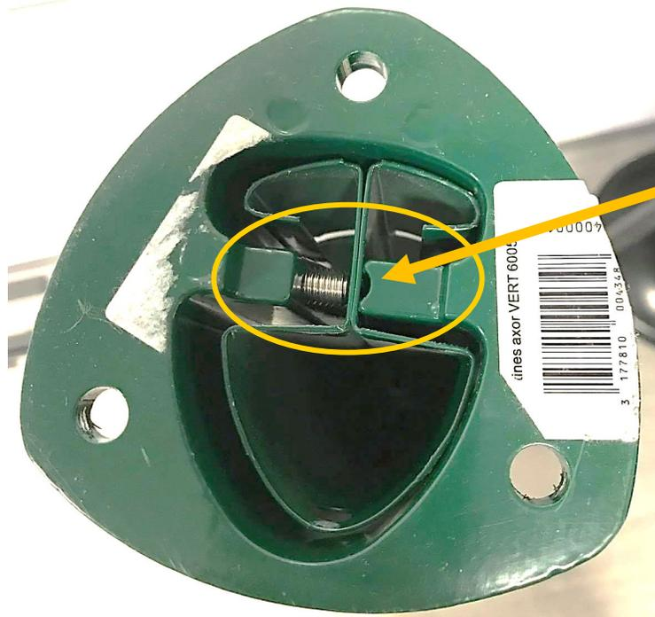
Les vis viennent **plaquer le poteau** contre le bord de la platine.
