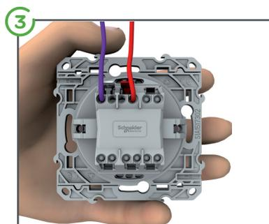
Enficher les fils dans les bornes auto-serrantes (Pour ôter les fils, exercer une pression avec le doigt sur les languettes)
