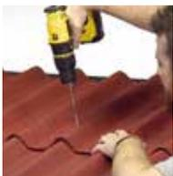
5 Fixez les plaques en utilisant les vis universelles au sommet des ondes, entre les guides de recouvrement. Attention de ne pas écraser les ondes !
