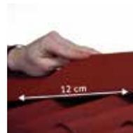
2 Installez les faîtières en recouvrant Recouvrez les éléments d'au moins 12 cm pour garantir une parfaite étanchéité.
