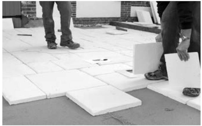
Mise en place des dallages sur lit de sable parfaitement de niveau.
