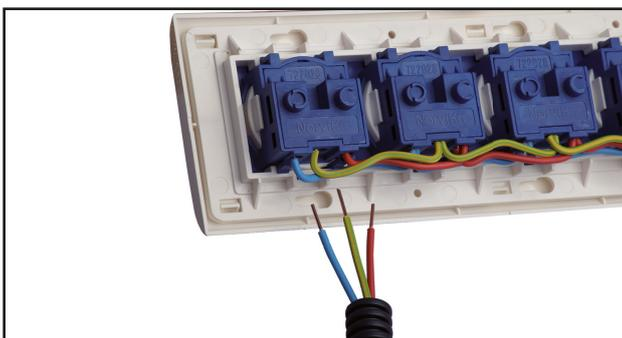
5. Raccorder les fils d'alimentation sur les mêmes bornes de branchement que la prise en faisant correspondre les fils de phase (rouge), les fils de neutre (bleu) et les fils de terre (jaune-vert).
