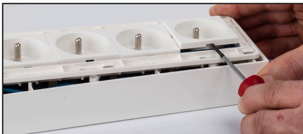
2. A l'aide d'un tournevis plat, retirer le cache de la prise située à l'une des extrémités du bloc prise.
