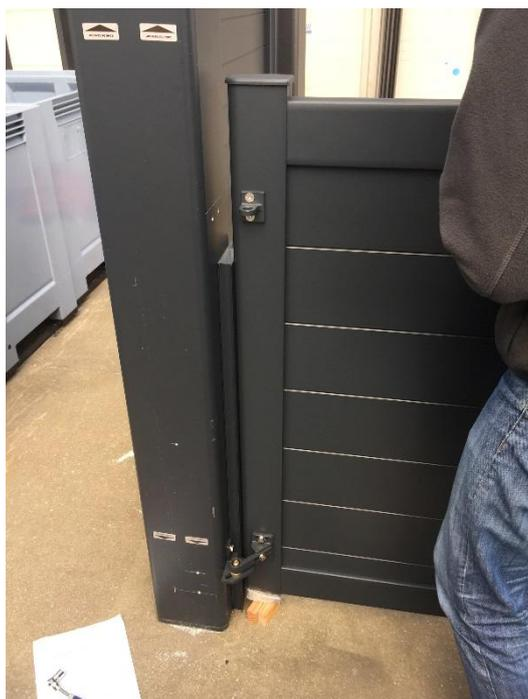
**Etape 8 :** Placez le gond haut pour le tracer, il est important de conserver les 25mm de jeu entre le pilier et le montant Tracez la hauteur des perçages
