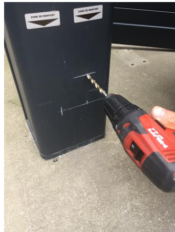
Perçage Ø 6,5mm
