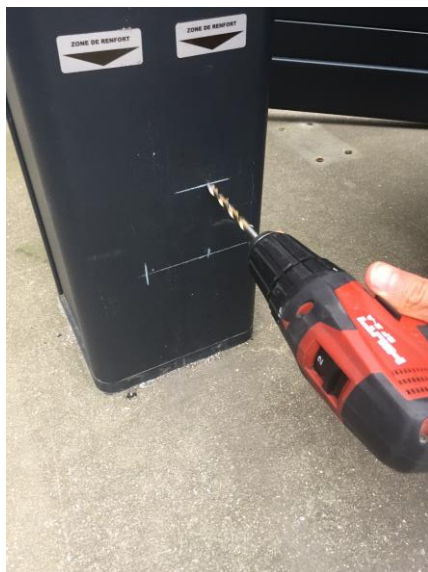
Perçage Ø 6,5mm
