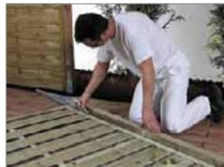
Réalisez un pré-perçage puis vissez les équerres. Aidez-vous d'un serre-joint pour pincer l'équerre et finir de la tourner en fin de vissage.
