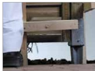
Gâcher du béton et versez-le autour des pieds des deux premiers poteaux, jusqu'au niveau du sol. Lissez la surface en pente pour que **l'eau s'écoule du pied du poteau vers le sol**.
