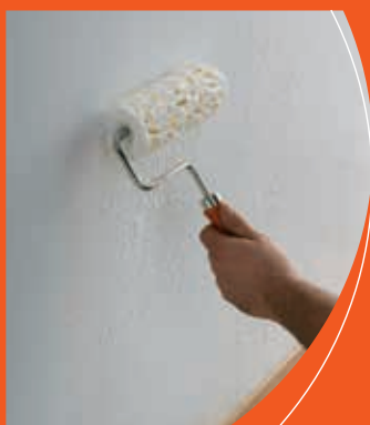
1 - Appliquer la colle vinylique au rouleau sur le mur de façon homogène
