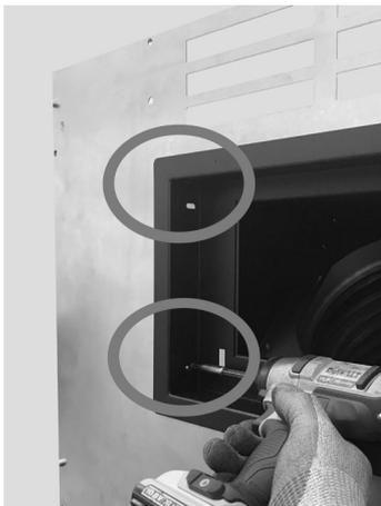
**Fig. 73 - Fixation externe de la trappe**
