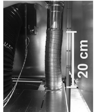
**Fig. 55 - Raccordement du tube flexible (vue arrière de l'insert)**
