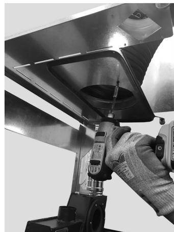
*Fig. 72 - Fixation du tuyau flexible*
