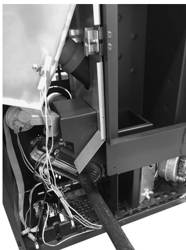
Fig. 78 - Nettoyage de le ventilateur ambiant
