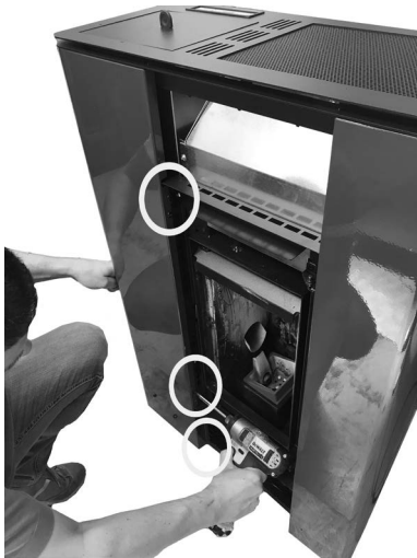
Fig. 56 - Retrait des vis 3
