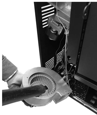
Fig. 80 - Nettoyage du ventilateur d'ambiance
