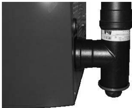
Fig. 72 - Nettoyage du conduit de fumée
