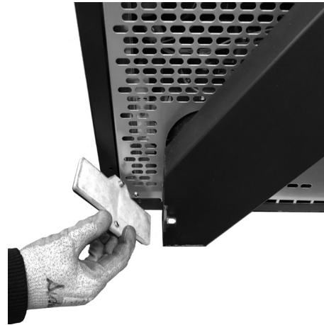
Fig. 85 - Nettoyage du conduit de fumée
