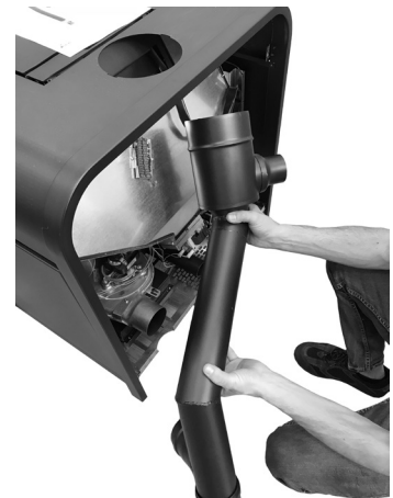
Fig. 58 - Placer le tuyau d'évacuation des fumées + concentrique
