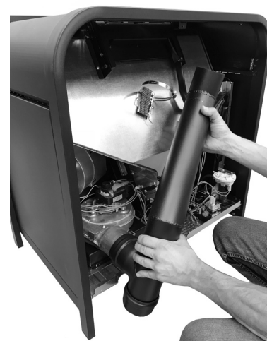
Fig. 35 - Placer le tuyau d'évacuation des fumées
