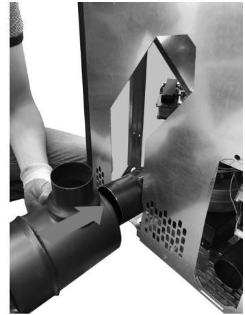
Fig. 52 - Raccorder le tuyau concentrique
