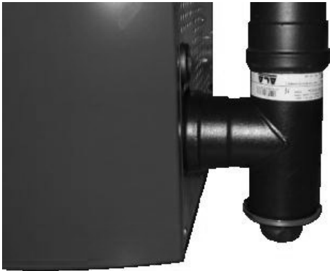
Fig. 84 - Nettoyage du conduit de fumée
