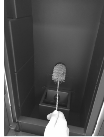
Fig. 24 - Nettoyage avec nettoie-pipes
