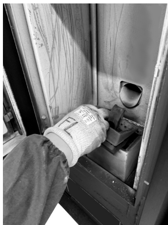
Fig. 21 - Extraction de le brasero
