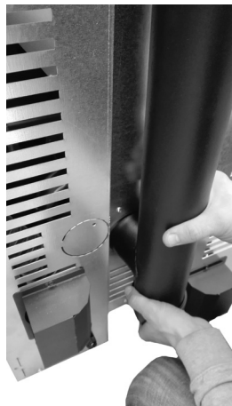
Fig. 52 - Raccorder le tuyau d.80 mm
