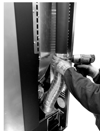
Fig. 61 - Fixer les tuyaux
