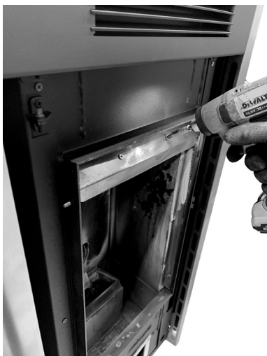
Fig. 74 - Retirer le déflecteur
