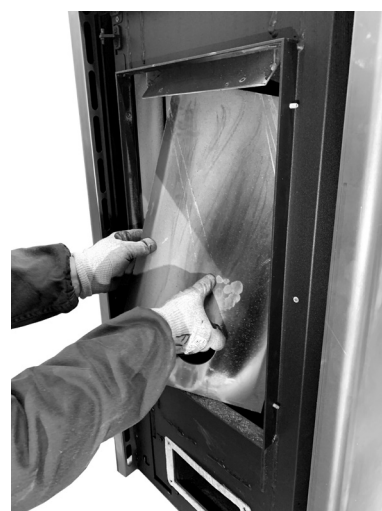
Fig. 79 - Retirer le panneau arrière du foyer
