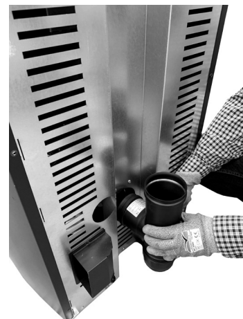
Fig. 47 - Raccorder le raccord en T
