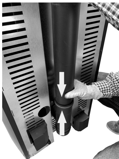
Fig. 49 - Raccorder les tuyaux
