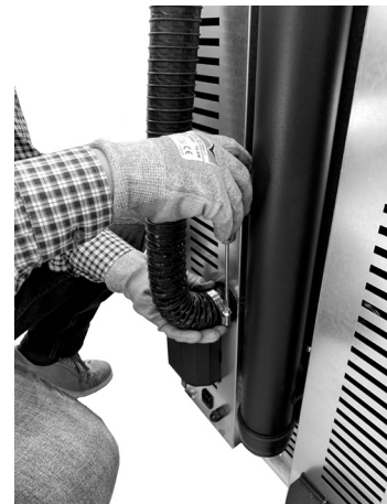
Fig. 53 - Raccorder le tuyau de l'air comburant
