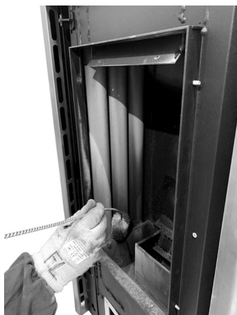
Fig. 80 - Nettoyer avec un goupillon
