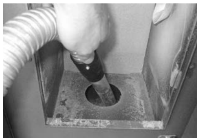
Fig. 27 - Nettoyage l'espace du brasero
