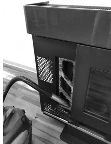
Fig. 33 - Nettoyage de la chambre des fumées
