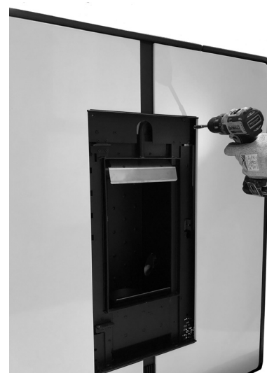
Fig. 46 - Fixation du revêtement
