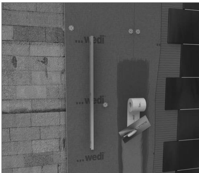
Pour les murs extrêmement irréguliers, utiliser des panneaux de construction wedi de 20 mm d'épaisseur et plus. Quel que soit l'âge et l'état des anciens supports, des murs propres et réguliers offrant une protection durable contre l'humidité et une isolation de la pièce peuvent être obtenus.
