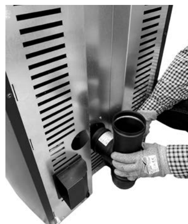
Fig. 59 - Raccorder le raccord en T
