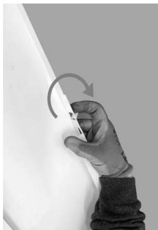
Fig. 51 - Plier les languettes
