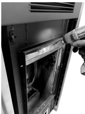
Fig. 104 - Retirer le déflecteur
