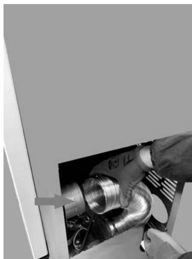
Fig. 80 - Détacher le tuyau flexible
