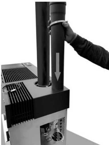
Fig. 90 - Introduire le tuyau de canalisation
