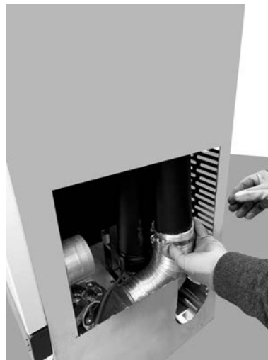
Fig. 91 - Raccorder les tuyaux
