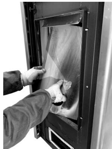
Fig. 109 - Retirer le panneau arrière du foyer
