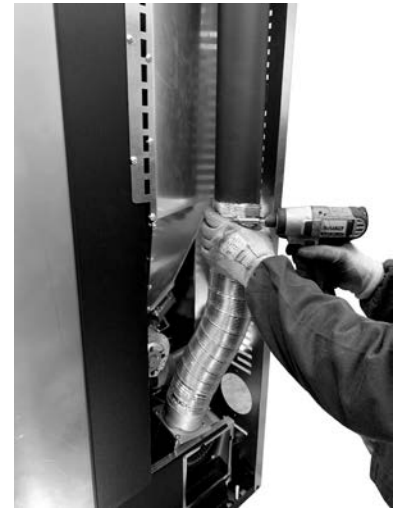
Fig. 74 - Fixer les tuyaux
