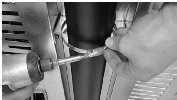
Fig. 66 - Bloquer avec un collier de serrage
