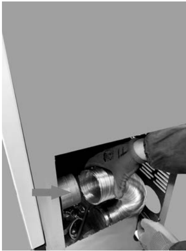
Fig. 87 - Détacher le tuyau flexible
