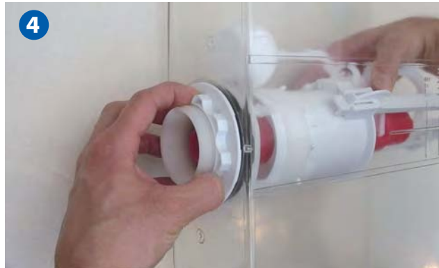
4 Insérer la base du mécanisme dans le réservoir et visser l'écrou.
