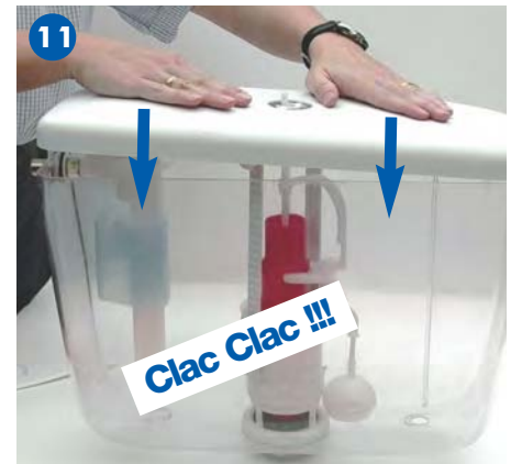
11 Mettre le couvercle sur le réservoir. L'étrier s'ajuste automatiquement à la bonne hauteur.
