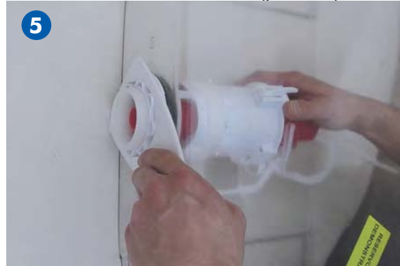
5 Pour une bonne étanchéité, visser 1/2 tour avec la clé.
