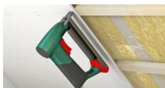
... ou à l'aide d'une agrafeuse pneumatique (agrafe sur ossature bois).
