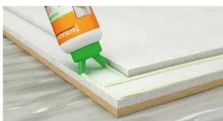
Appliquez la colle en deux cordons sur la battue inférieure d'une plaque avant de la recouvrir par la battue supérieure de la plaque suivante.
