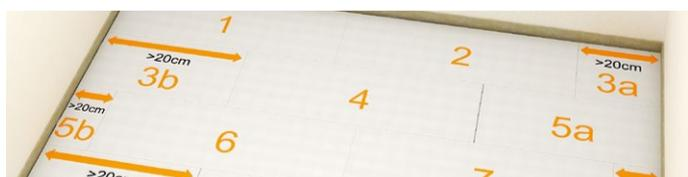
Procédez à l'assemblage des plaques de sol par rangées successives en prenant soin de décaler les joints
