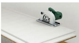
A l'aide d'une scie circulaire, découpez les 2 parties supérieures de la plaque qui viendra se positionner dans l'angle le plus éloigné de l'accès de la pièce ...
