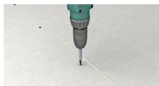
Vissez ou agrafez les battues l'une sur l'autre, de façon à assurer la compression nécessaire à la parfaite tenue du collage.
