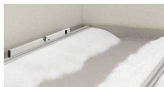
Versez les granules d'égalisation **fermacell** sur 20 cm de large sous forme de « digue » et nivelez à hauteur désirée en tenant compte de l'épaisseur de la chape sèche.
