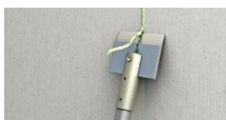
Après séchage et expansion de la colle (12 à 36 h), raclez les bavures de colle et arasez les passages de têtes de vis à l'aide d'un couteau à colle **fermacell** ou d'un riflard.
