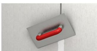
Surfacez les joints et rebouchez les passages de fixations (vis ou agrafes).
