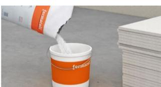
Versez environ 1 kg d'enduit pour joints **fermacell** dans environ 0,6 litres d'eau. Laissez reposer 2 à 5 minutes. Remuez de façon à obtenir un mélange homogène sans grumeaux.
