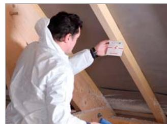
Puis, réhaussez l'ouverture de la trappe avec les cartons prévus à cet effet dans le kit d'installation.
