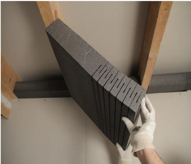
K Therm Chevron® est un panneau en polystyrène expansé gris entaillé, destiné à réaliser l'isolation :
