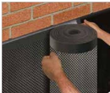
Dérouler LA PROTECTION DE SOUBASSEMENT sur le support. Utiliser les rondelles d'étanchéité et clous LA PROTECTION DE SOUBASSEMENT pour une fixation optimale (recouvrement entre rouleaux : 20 cm).
