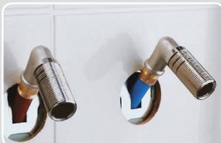
il suffit de dévisser les contre-écrous pour accéder au raccordement
